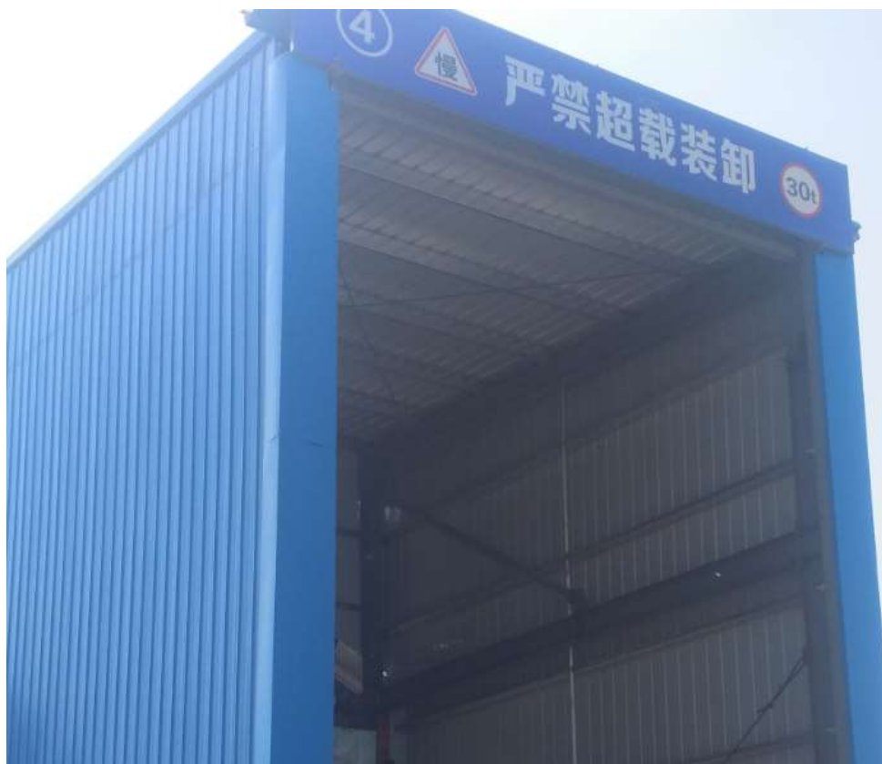
图 4-4 泊位卸货停车处密闭现场照片
