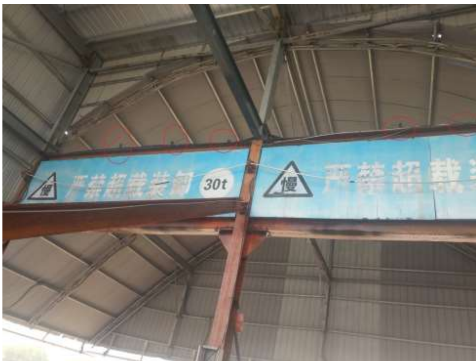
图 4-2 泊位龙门吊上的喷洒装置现场照片
