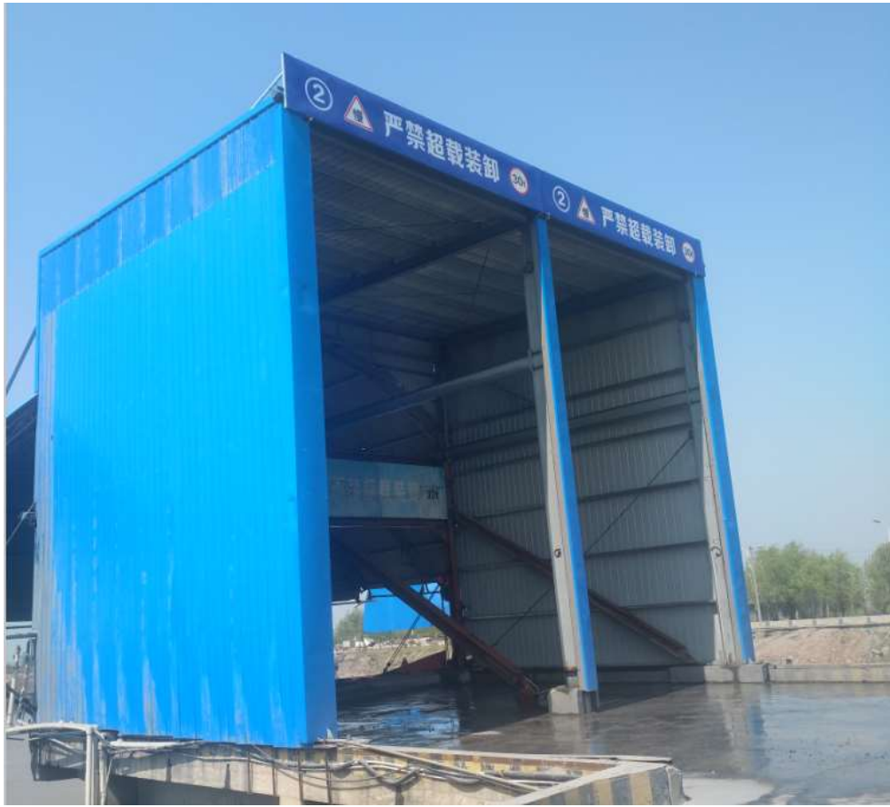
图 4-4 泊位卸货停车处密闭现场照片
