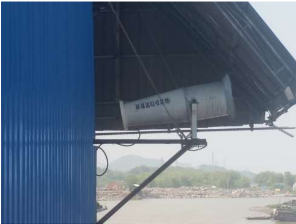
图 4-3 泊位卸货增装喷雾炮现状图
