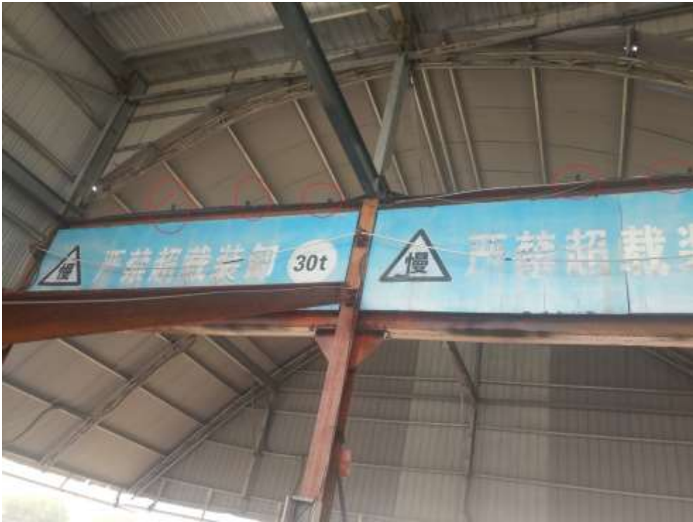
图 4-2 泊位龙门吊上的喷洒装置
